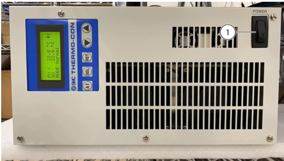
Figura 4-3 Interruptor de corriente del módulo de refrigeración
